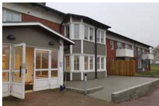
Även utsidan har renoverats samtidigt som man har byggt en ny uteplats.
