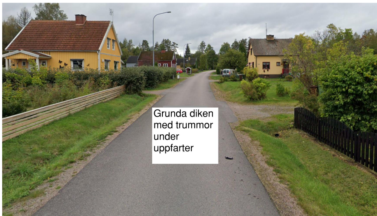
Figur 14. Exempel på grunda diken längs väg med trummor under uppfarter.
